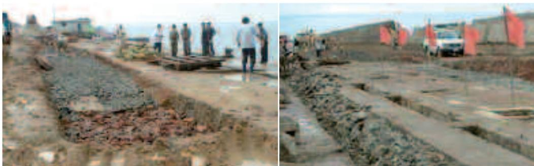
Repositionnement du « couvercle » du barrage après renforcement des cellules, le tout recouvert de trois couches de rochers différents, puis une couche de terre et de gravillons pour l'aspect final
