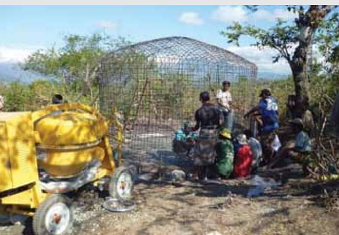
Mise en place de l'armature métallique pour la construction d'un réservoir en ferrociment - Province d'Oecusse, Timor Oriental
