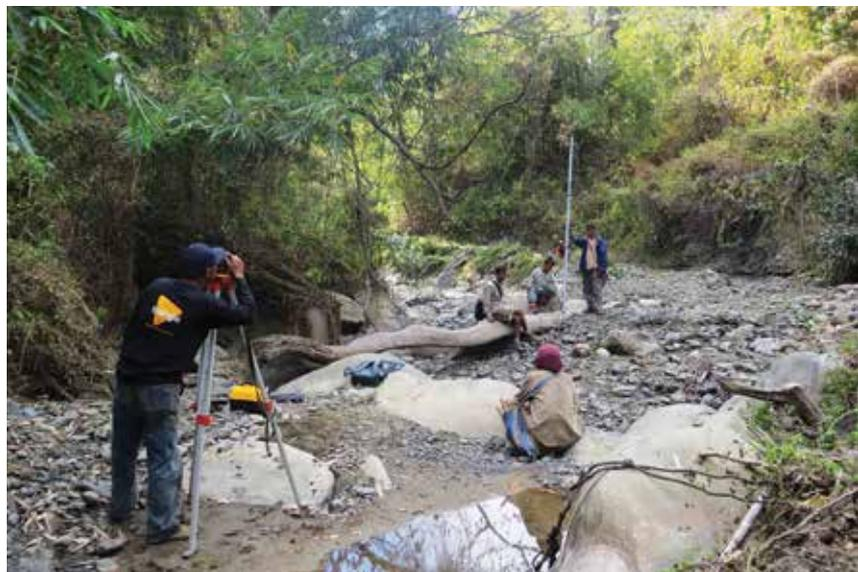
Birmanie - Relevé topographique destiné à quantifier les matériaux de construction pour un ouvrage d'irrigation. Relevé effectué par les communautés avec l'appui technique des équipes de Triangle G H - Photo : Thang Kip Lian / Triangle G H
