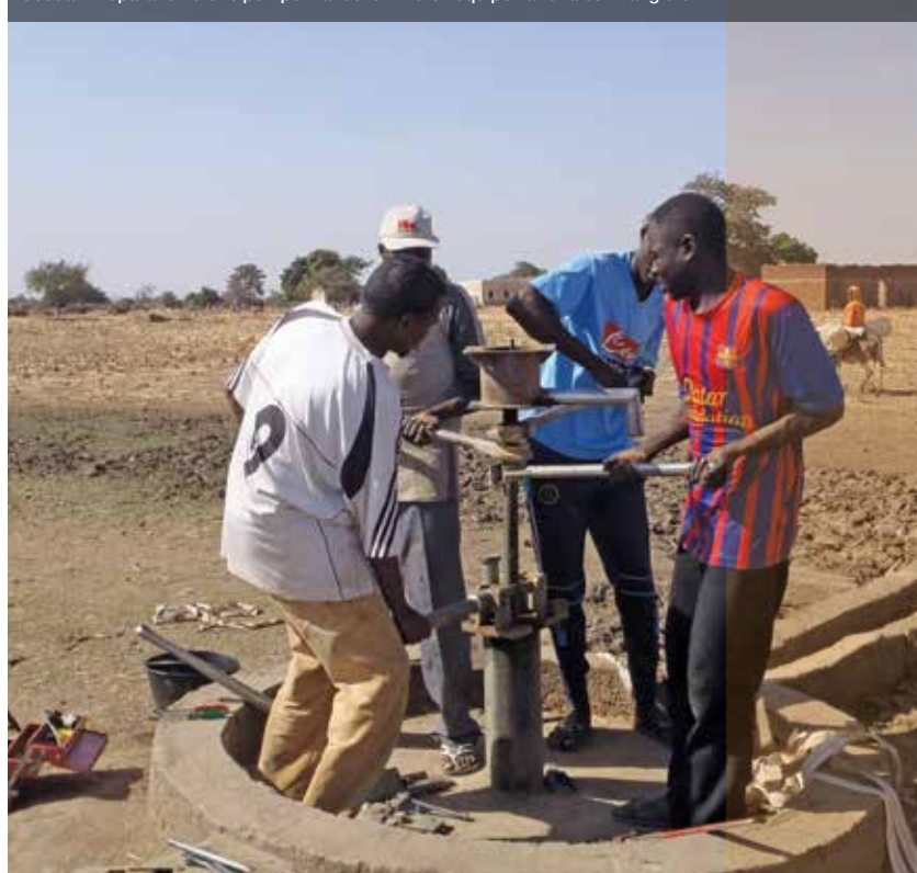
Soudan. Réparation d'une pompe manuelle. Photo : équipe nationale / Triangle G H
