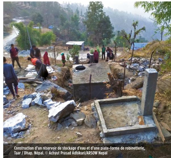
Construction d'un réservoir de stockage d'eau et d'une plate-forme de robinetterie, Taar / Dhap, Népal. © Achyut Prasad Adhikari/ARSOW Nepal
